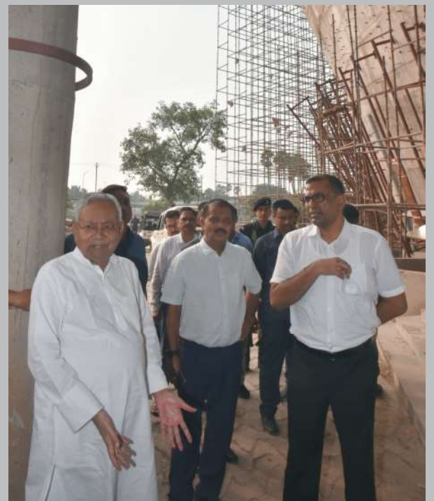
बापू टावर के निर्माण कार्यों का निरीक्षण करते माननीय मुख्यमंत्री श्री नीतीश कुमार एवं भवन निर्माण के सचिव श्री कुमार रवि
